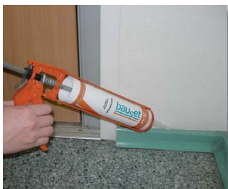
герметизация швов в общестроительных работах
