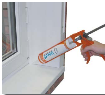
герметизация швов при установке откосов
