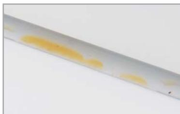
достичь идеального прилегания уплотнителя к полу часто не представляется возможным, поэтому неизбежно попадание влаги и мусора под уплотнитель, а использование цоколя с широким прозрачным уплотнителем отрицательно отражается на внешнем виде кухни
