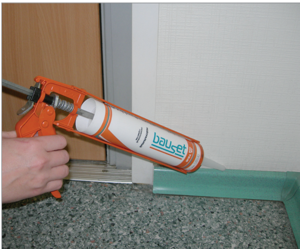
Герметизация швов в общестроительных работах
