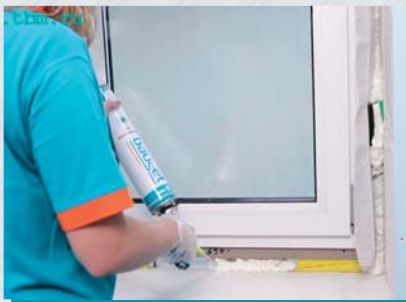
Рис. 11. Запенивание монтажного шва
