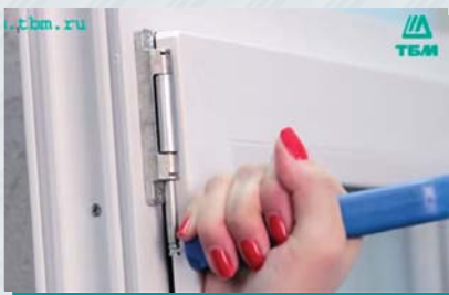
Рис. 1. Снятие штифта
