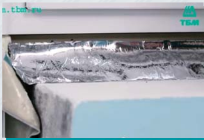
Рис. 13. Установка металлизированной ленты
