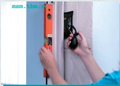
Рис. 9. Выравнивание окна
