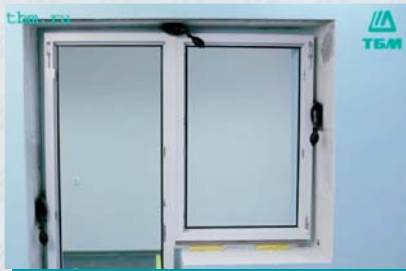
Рис. 4. Предварительная установка рамы
