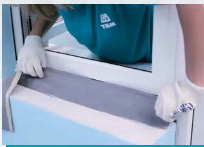
Рис. 10. установка внешней мембранной ленты
