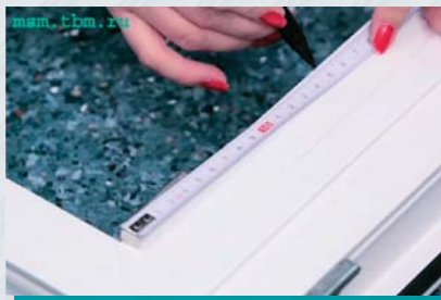
Рис. 7. Разметка под крепеж
