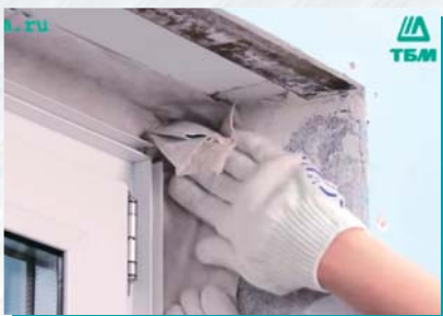
Рис. 12. Угловое соединение внутренней ленты
