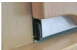
2. Закрывание двери. Нажим на расцепную кнопку уплотнителя со стороны петель при ее контакте с дверной коробкой. Уплотнительный профиль опускается вниз к полу.
