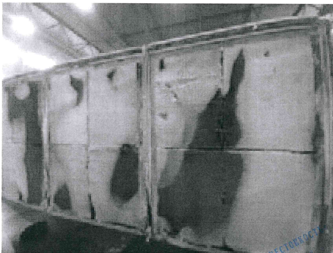
Фото 10. Образец после испытания (со стороны нагрева, демонтаж)
