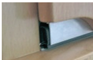
2. Закрывание двери. Нажим на расщепную кнопку уплотнителя со стороны петель при ее контакте с дверной коробкой. Уплотнительный профиль опускается вниз к полу.
