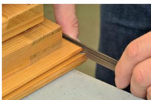
Вставить уплотнитель в паз до места отрезания
