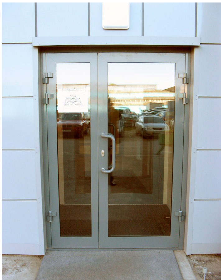
Объект: г. Новосибирск. Офисный Центр Система: Серия S50
